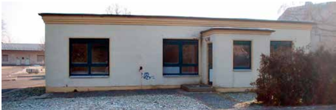
So sah das Gebäude 2004 aus (Fotos: Udo Jedlicka)
