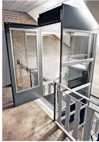
Die baulichen Vorleistungen sind auf ein Minimum reduziert, weshalb sich ein Homelift ideal auch für den nachträglichen Einbau eignet. Hier wurde zusätzlich noch ein Dachfenster vom Zimmermann installiert, um Kopffreiheit zu schaffen. (Fotos: epr/Ammann & Rottkord)
