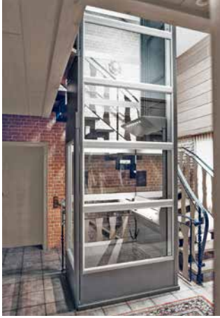
Die baulichen Vorleistungen sind auf ein Minimum reduziert, weshalb sich ein Homelift ideal auch für den nachträglichen Einbau eignet. Hier wurde zusätzlich noch ein Dachfenster vom Zimmermann installiert, um Kopffreiheit zu schaffen. (Fotos: epr/Ammann & Rottkord)
