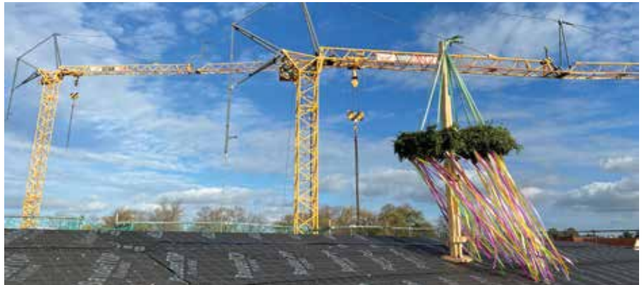
Der Richtkranz auf dem Rohbau
