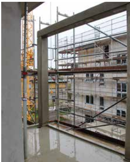
Ausblick aus dem Rohbau
