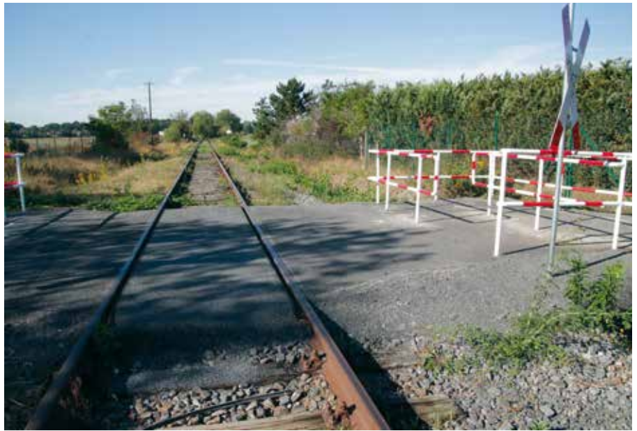
Mit dem Gutachten steht eine Reaktivierung der Strecke Beucha–Brandis bis nach Trebsen auf dem Prüfstand.
