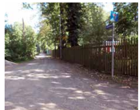
Mit einer speziellen Maschine wird die sandgeschlammte Schotterdecke oberflächlich auf eine Höhe abgefräst, um im Anschluss wieder verdichtet zu werden.
