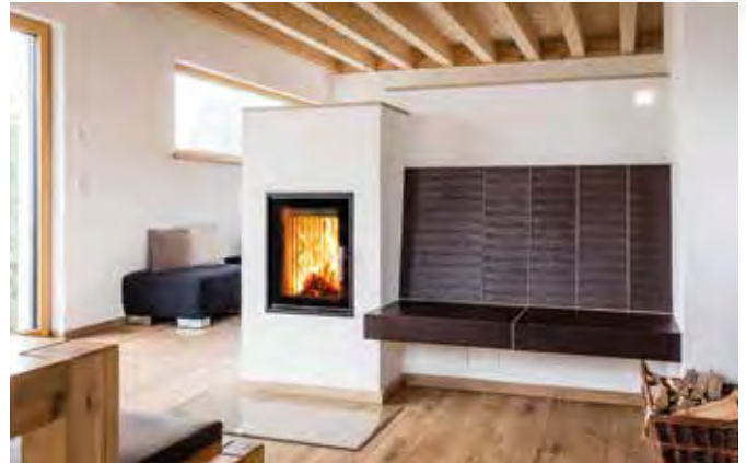
Holzfeuerung speist Heizungsanlage und sorgt für heißes Wasser. Foto: Leda Werk/akz-o
