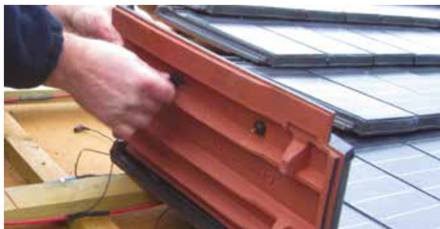
Intelligent und ästhetisch: Die Solardachziegel lassen sich wie normale Dachziegel verlegen und sind durch geprüfte Steckverbindungen sicher miteinander verbunden. txn-Foto: Autarq/Creaton
