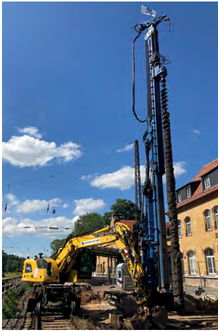
Bagger entfernen den Unterbau am Bahnsteig 1. (Quelle: DB S&S AG)
