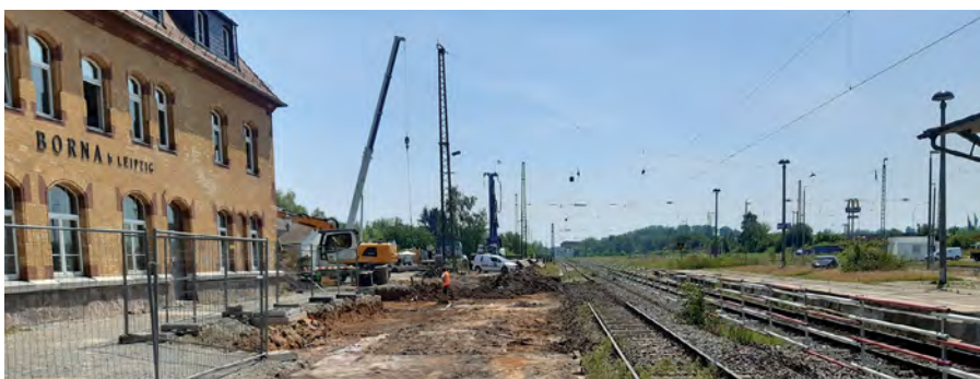
Am Bahnsteig 1 werden der Belag und die Kanten zurückgebaut. (Quelle: DB S&S AG)
