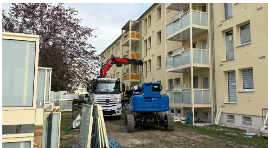
Anbau der neuen Balkone in der Heinrich-Heine-Straße
