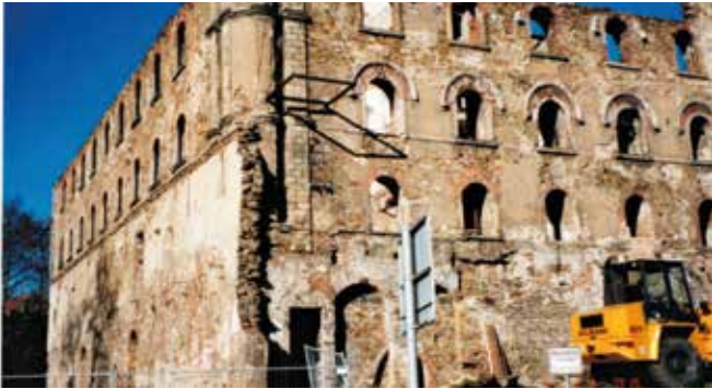
Schlossruine vor dem Umbau, Foto: Stadtverwaltung Großenhain (Archiv)
