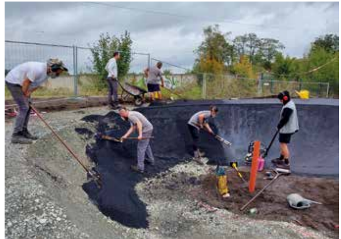
Mitarbeiter der Firma Pumptrack.de formen per Hand die Bitumenstrecke. Foto: Stadtverwaltung Großenhain/JW
