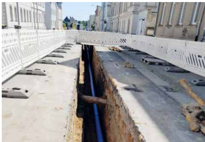
Neuverlegung der Rohrleitungen auf der Lange Straße.
