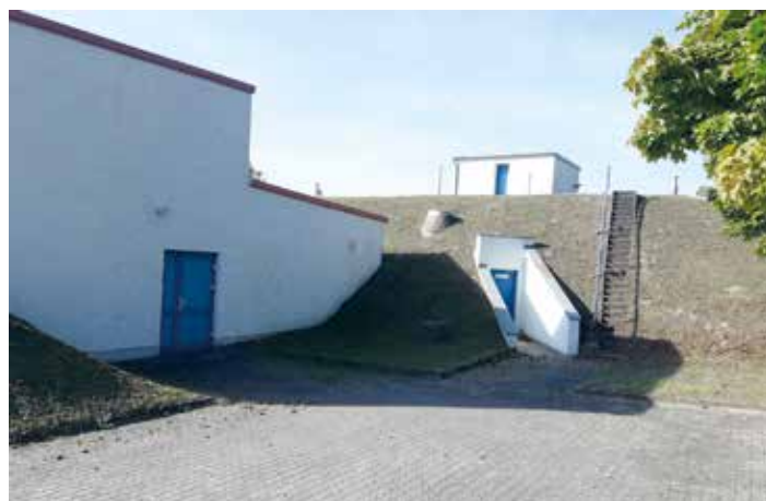
Das Wasserwerk Schönfeld soll erweitert werden.
