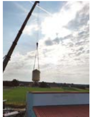
In das Wasserwerk Schönfeld wurden neue Filter eingehoben
