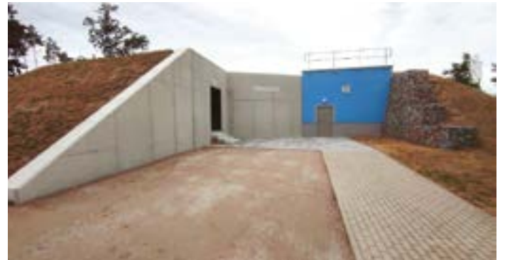
Am Wasserwerk Tauscha wurde ein nicht mehr sanierungsfähiger Reinwasserbehälter durch einen Neubau ersetzt.
