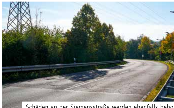
Schäden an der Siemensstraße werden ebenfalls behoben.
