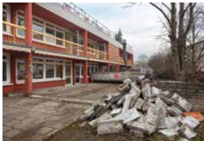
Abriß des Altbaus der Kita „Am Wasserturm“
