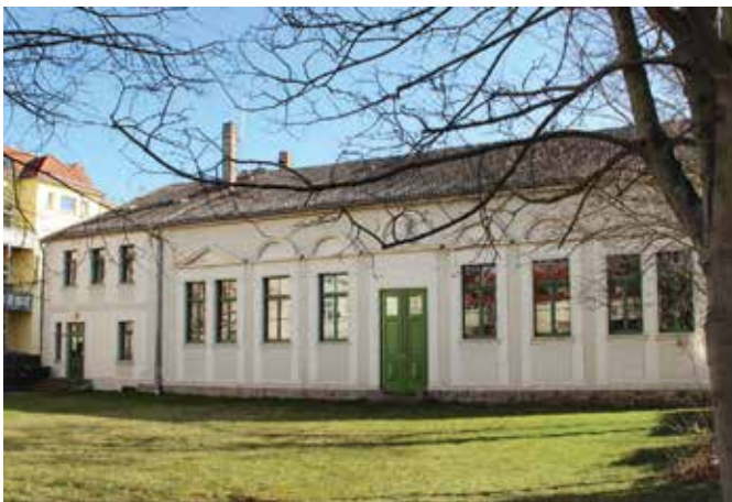
Bei der Sanierung der Turnhalle in der Schulstraße wird u. a. das Dach erneuert, ein neuer Fußballboden eingebaut und der Innenbereich denkmalgerecht gestaltet. (Foto: Daniel Kreusch)
