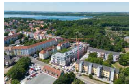
Markkleeberg aktuell Richtfest in der Sonnesiedlung
