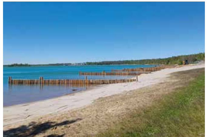
Im Rahmen der Sanierung des Auenhainer Strandes wurden u. a. 14 Bühnen errichtet und 500 Tonnen Feinsand aufgebracht. (Foto: EGW)
