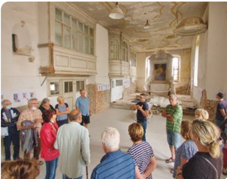
Offene Baustelle: Baupfleger Tilmann Dorn informierte die Besucher über das Projekt Kultur-Kirche und die laufenden Arbeiten.
