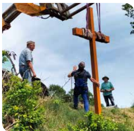
ein neues Kreuz wird errichtet (19.05.2022)
