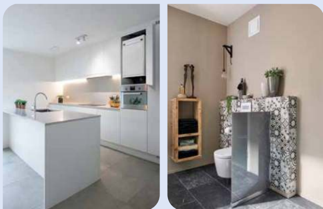
Spürbarer Effekt – optisch dezent: In den Räumen sind von einer zentralen x-well Wohnraumlüftung nur die Zu- und Abluftdurchlässe zu sehen. Hier gibt es ästhetische Lösungen für unterschiedlichste Einbausituationen und Gestaltungswünsche. (Foto: Kermi GmbH/akz-o)
