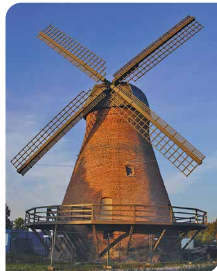
Zwei Jahre später – die Mühle in Pumpėnai ist fast fertig. (Fotos: Frank Thomas)
