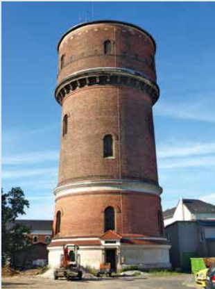
Der Wurzener Wasserturm
