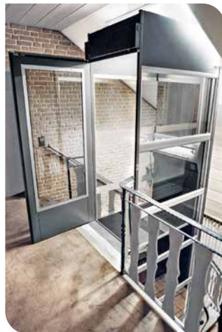
Die baulichen Vorleistungen sind auf ein Minimum reduziert, weshalb sich ein Homelift ideal auch für den nachträglichen Einbau eignet. Hier wurde zusätzlich noch ein Dachfenster vom Zimmermann installiert, um Kopffreiheit zu schaffen.
