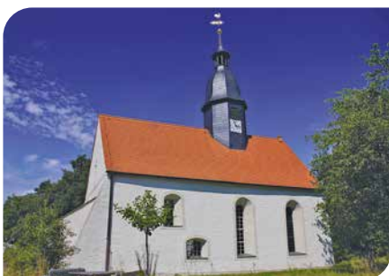
An der kleinen Dorfkirche in Körlitz lädt ein Rastplatz mit Wasserhahn für die Pilger und Radler ein.
