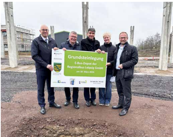
Im Hintergrund sind die Fundamente und Betonträger des neuen Depots bereits zu sehen: Regionalbus-Geschäftsführer Andreas Kultscher, Bürgermeister Holger Schulz, Landrat Henry Graichen sowie Vertreter der Fördermittelgeber und von Daimler Buses legten Ende März den Grundstein. (v.l.n.r.)
