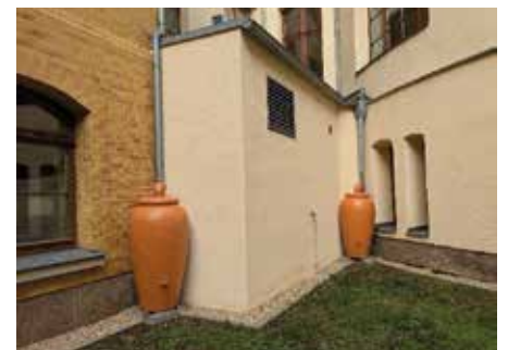
Zwei Wasserspeicher, jeweils mit einem Volumen von 500 Liter, im Hinterhof der Stadtbibliothek Leipzig, (Quelle: Scheller)
