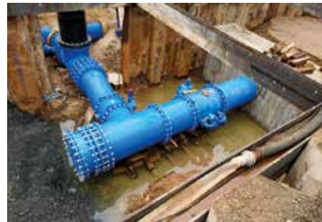
Einzuggrube mit Widerlager
